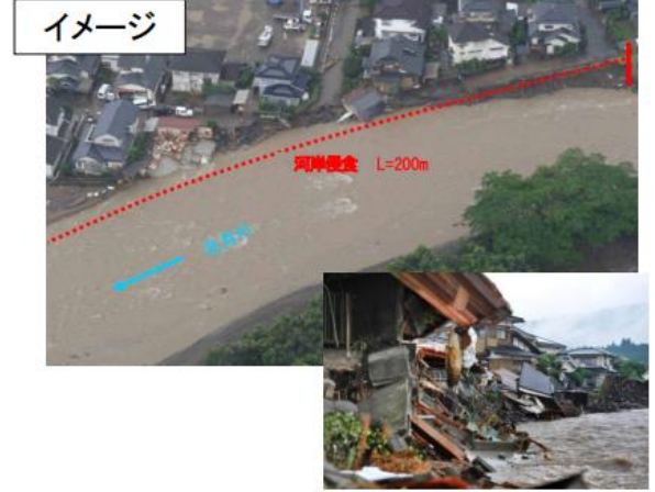
河岸侵食により家屋倒壊した状況
