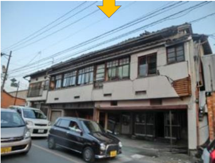
4/15本震前（建築研究所報告より）
