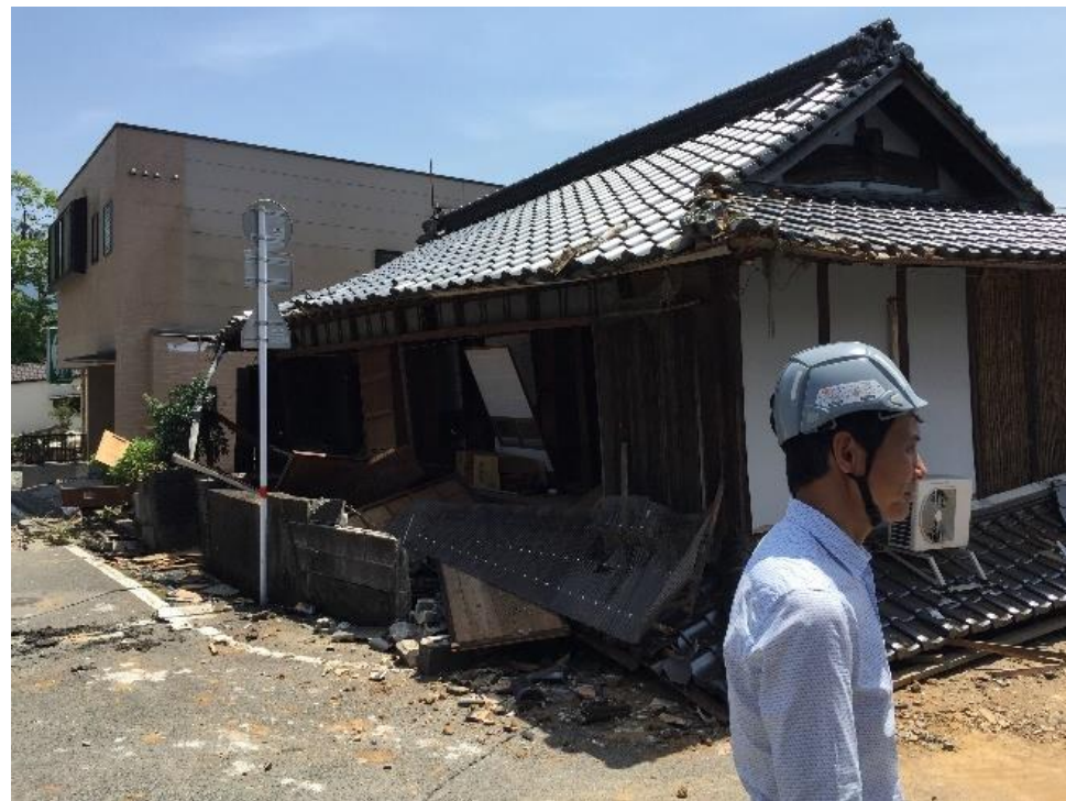
土壁・全面開口
